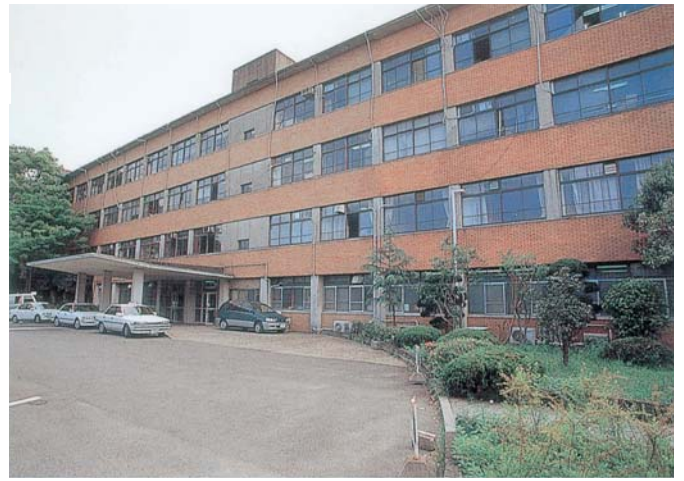
現在の文学部本館。竣工後40年近くたった今も、増築による継ぎ足しのあとが、外壁の色合いの微妙な違いからわかる。
