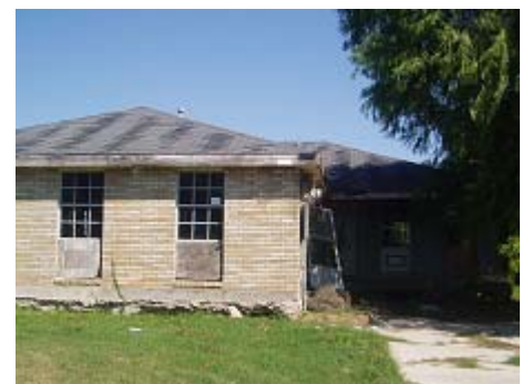
コミュニティ内に残された、カトリーナ後、地域を離れた住民の未修理の家
