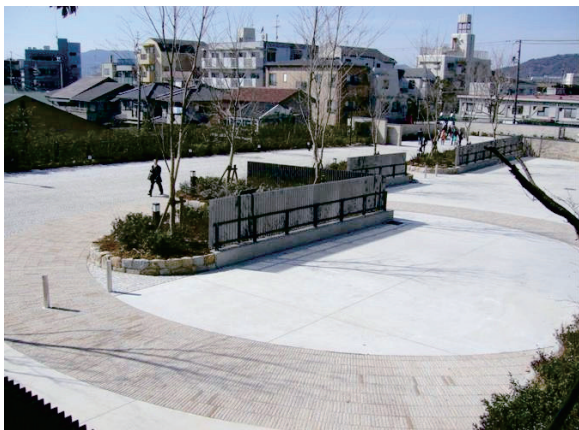
整備された「阪大坂」と待兼山5号墳周濠の表示
