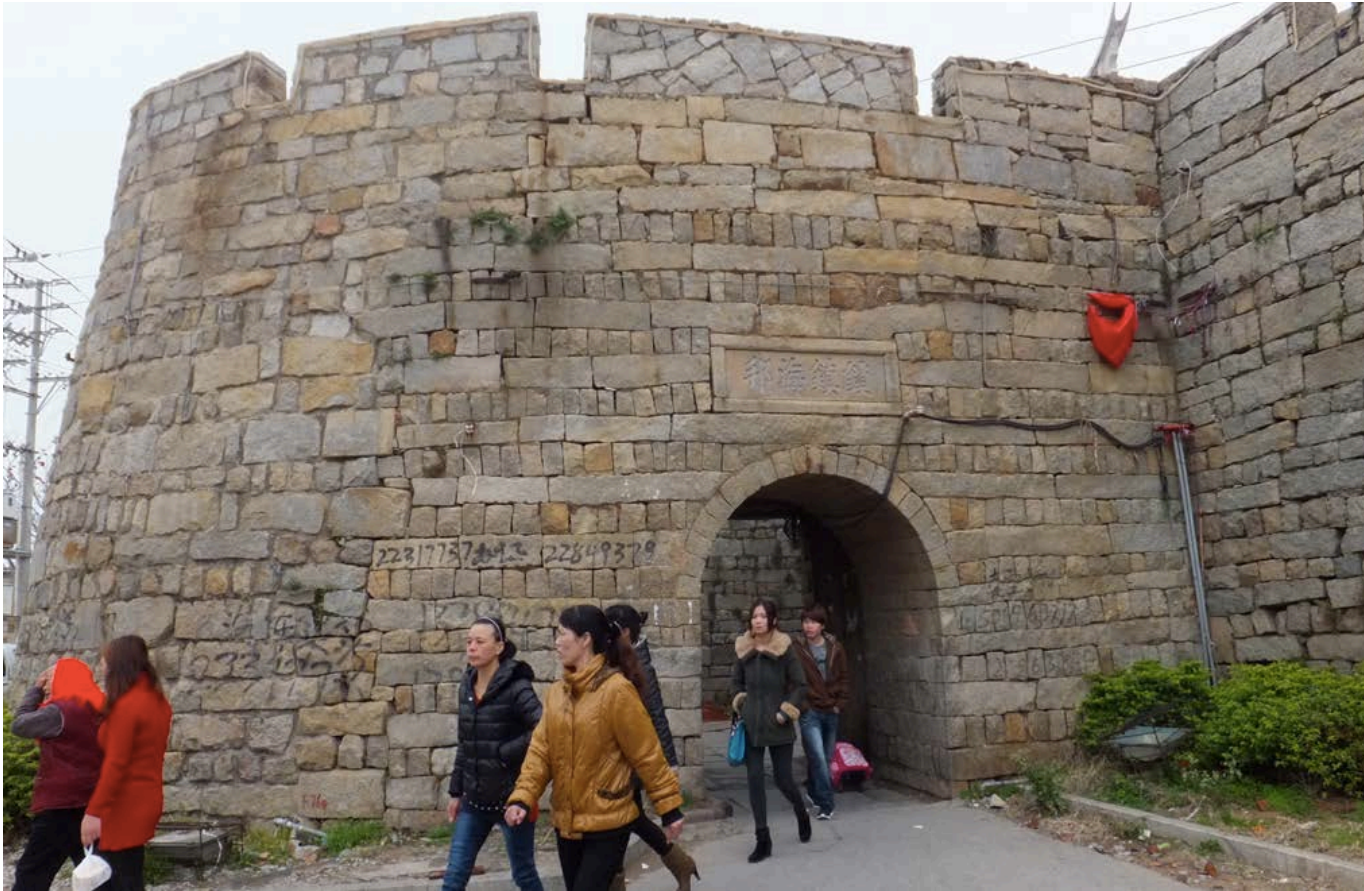
【図 3】明代に築造された崇武所の城壁に見える石磚の並べ方
