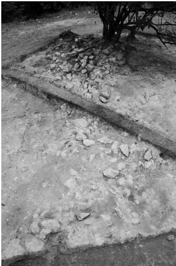
1 陥没坑に落ち込んだ小礫群（南から）
